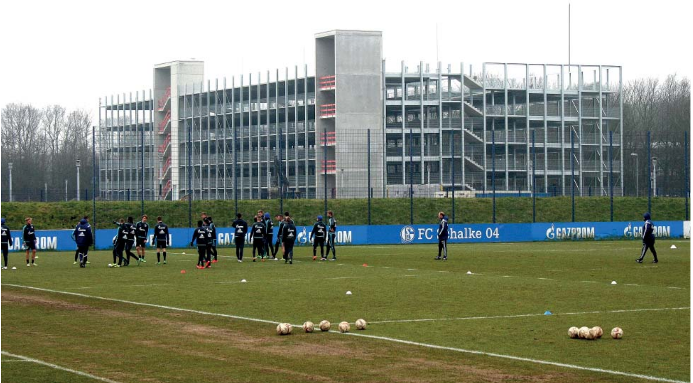
Baufortschritt Berger Feld.
