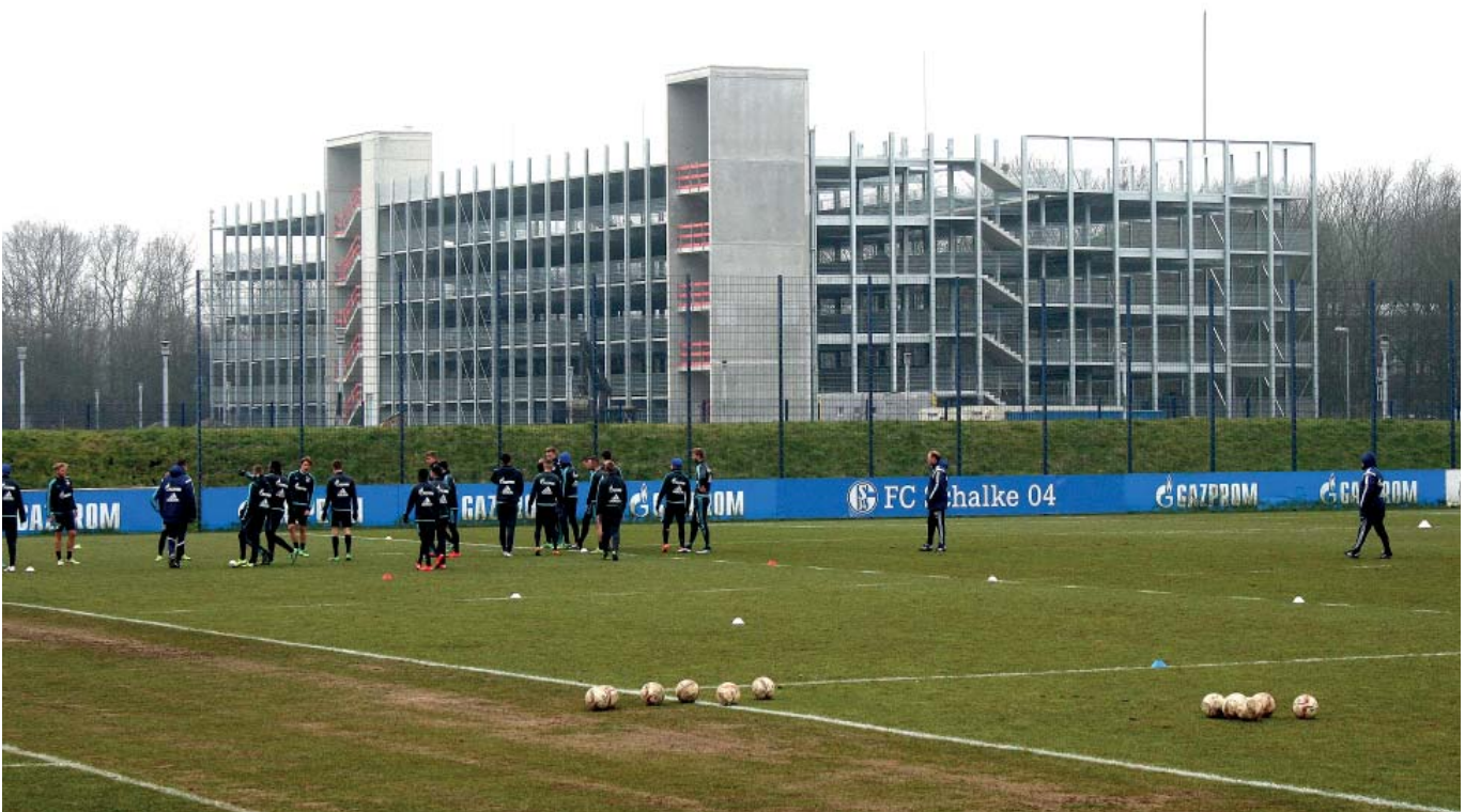
Baufortschritt Berger Feld.
